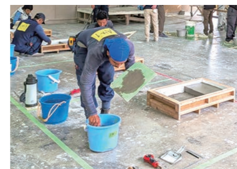
左官工事作業
