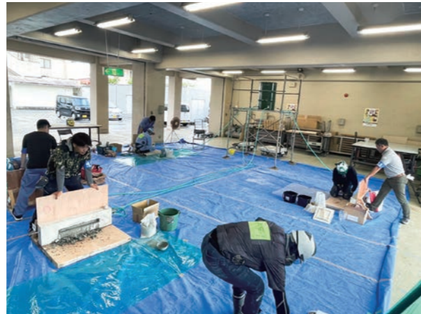
セメント系防水工事作業
